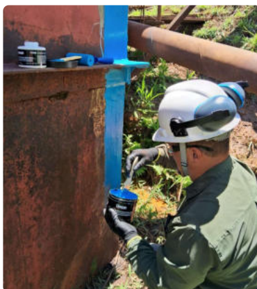
Proteção de Tanque
