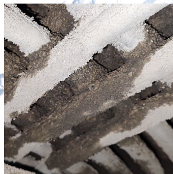
Reversão da incrustação e restauração da capacidade de troca térmica da torre evaporativa
