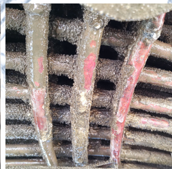
Reversão da incrustação e restauração da capacidade de troca térmica da torre evaporativa
