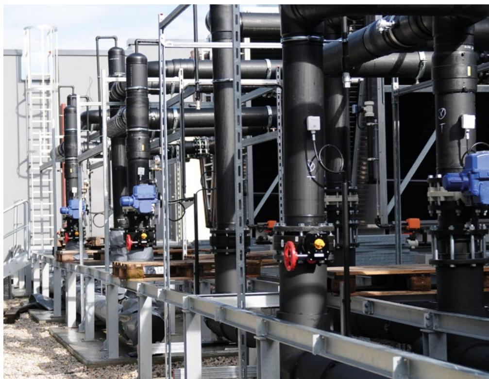
Os tubos e juntas de PE 100-RC instalados sobre o solo, com as dimensões de diâm. ext. 280 mm em SDR 17, são usados para ligação entre torres de refrigeração e grupos frigoríficos.
