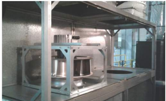
Retrofit em AHU - Benefícios obtidos: Economia de energia e ganho de capacidade
