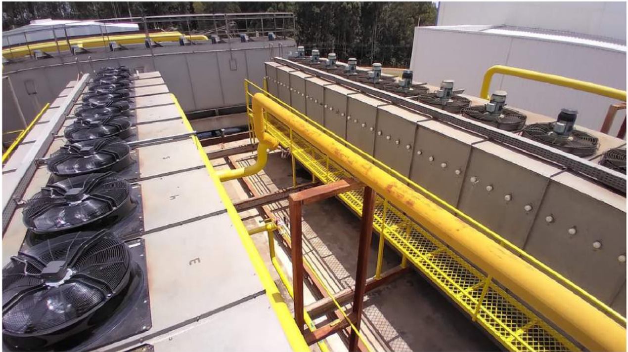
Substituição de ventilador em condensador evaporativo para ganho de capacidade
